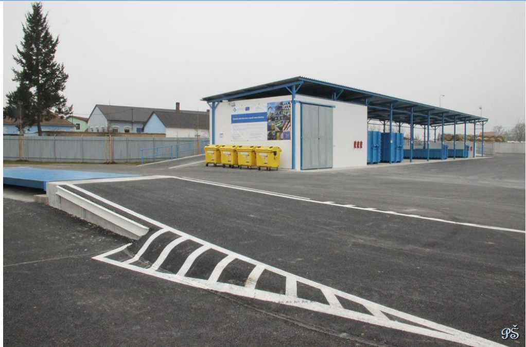
Zdroj: fotodokumentace příjemce
